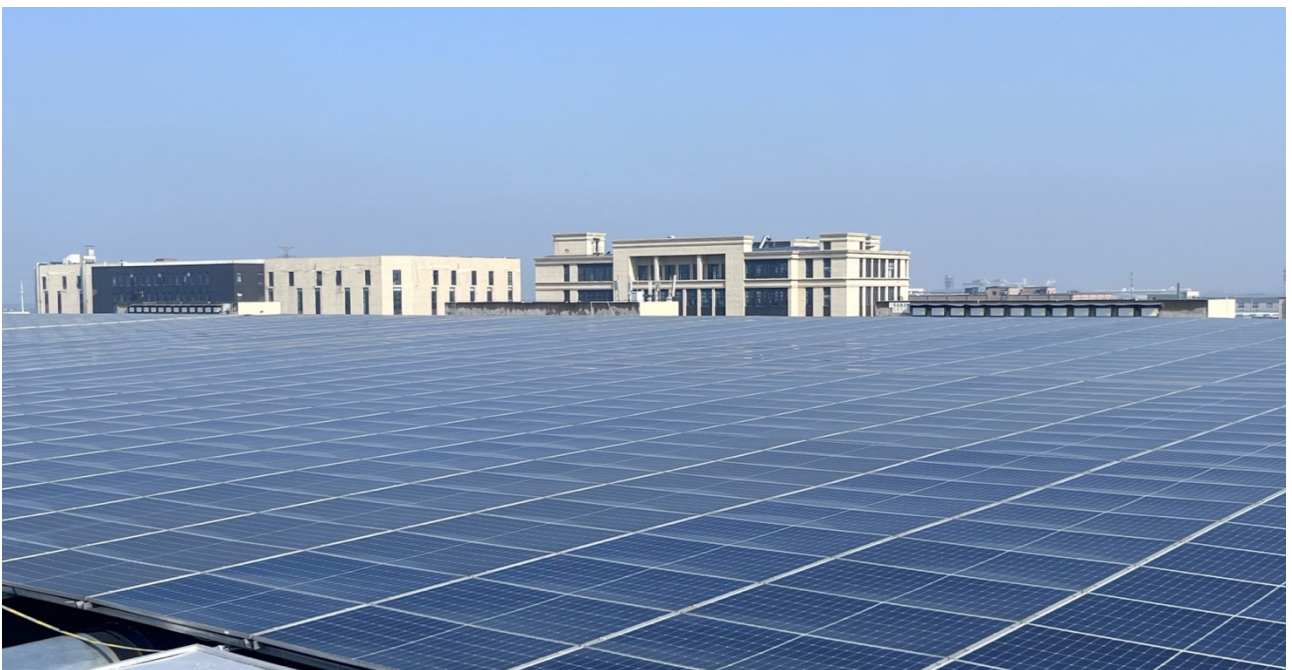
图注：嘉善厂区屋顶光伏航拍
